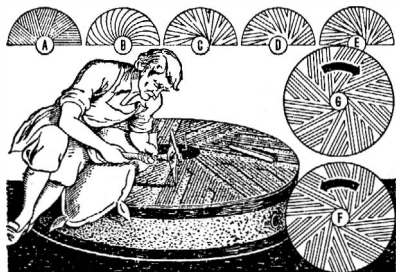
FIGURA 118—Preparazione a mano di macine. Sono qui mostrati alcuni disegni originali. Le macine fisse e rotanti erano preparate nello stesso modo. (A) Periodo tardo romano; (B) 18° secolo; (C), (D), (E) 19° secolo. (F) e (G) macine destrorse e sinistrorse con scanalature a quattro quarti.
